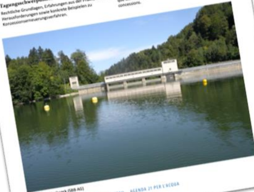
Staumauer Ebnatwerk (SBK AG)
