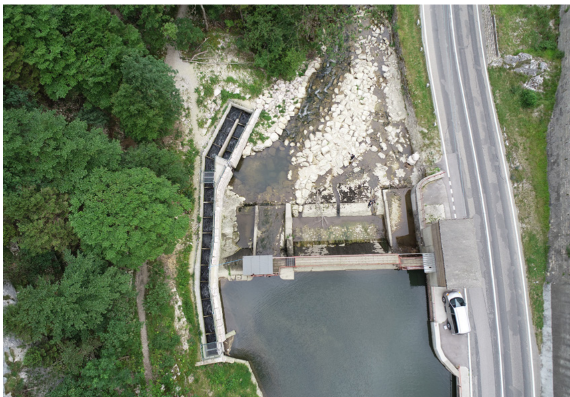
Figure 1: La prise d'eau de la centrale hydro-électrique de Gorges de Court avec Échelle à poissons, Aquarius, Jérôme Plomb, 2020.
