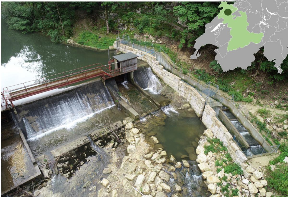
Figure 2: La prise d'eau de la centrale hydroélectrique de Gorges de Court, Aquarius, Jérôme Plomb, 2020.
