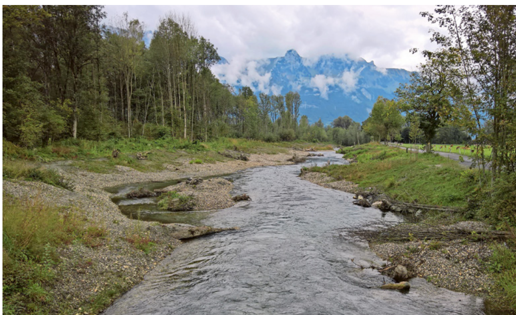
... und ein Jahr nach Bauabschluss im Juni 2018.
