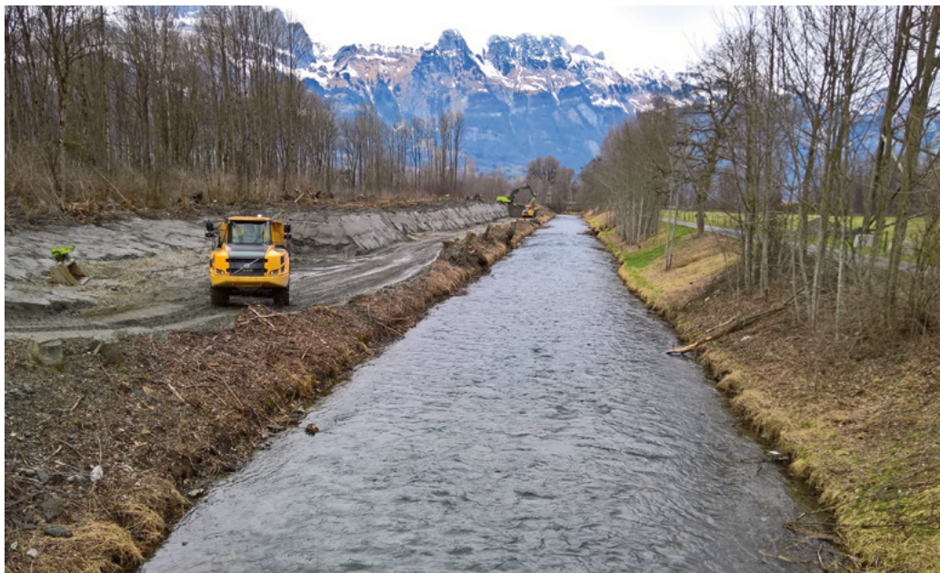
Aufweitungsstrecke während des Baus im Januar 2017...
