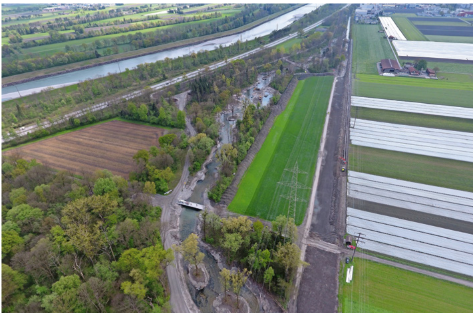
Der versetzte Flusslauf im reaktivierten Auenwald und der zugeschüttete Kanal. Links oben sind die A13 und dahinter der Alpenrhein zu erkennen. (Bilder: © Amt für Wasser und Energie Kt. St. Gallen)
