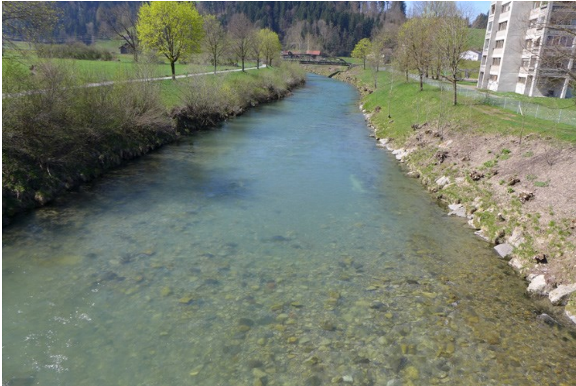
Fig. 35 La Thur vue du pont de la Waisenhausstrasse (GEWISS km 39.9) vers l'aval : le fond du lit est étroit et dégagé et les berges sont abruptes et peu structurées (2015).
