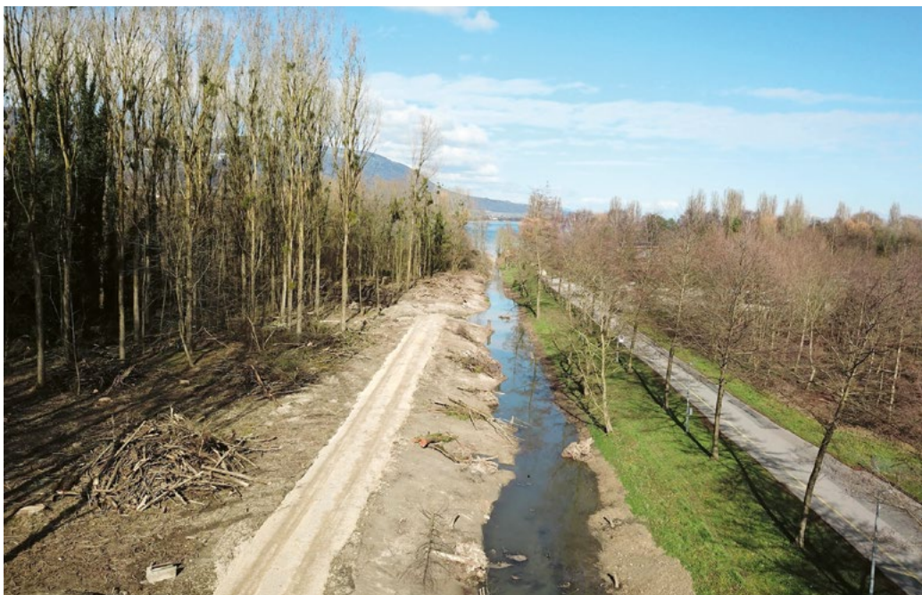
Les renforcements de berges existants ont été supprimés et le lit du Mujon a été modulé en diversifiant les pentes des berges et la topographie du chenal. En rive gauche, les cultivars de peupliers ont été abattus afin de permettre le développement de milieux forestiers conformes à la station. (© biol conseils)
