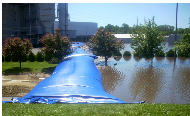
Fig. 93 : Digue de protection mobile remplie d'eau
