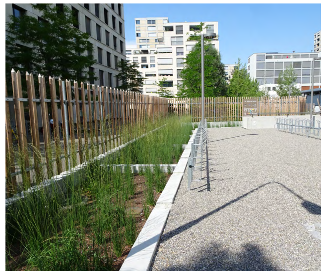
Fig. 59 : Fossés ouverts destinés à l'évaporation et à l'infiltration
