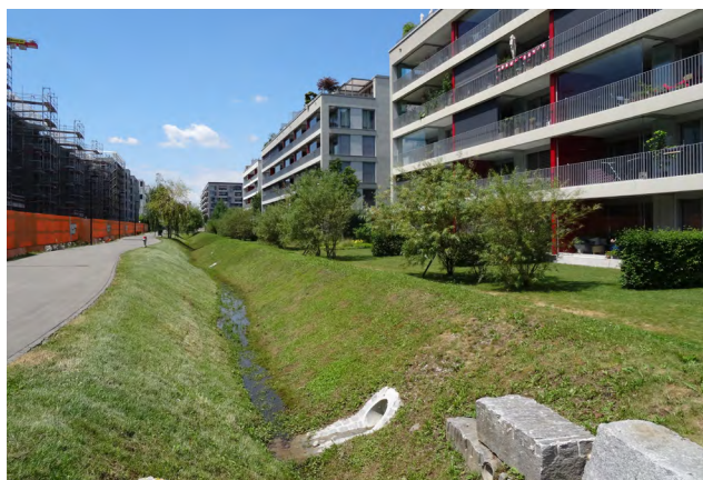
Fig. 57 : Les fossés charrient l'eau de pluie ruisselant des immeubles jusqu'au lac de l'Opfikerpark.
