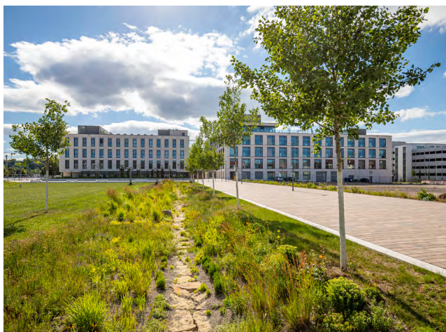
Fig. 78 : Une noue d'infiltration filtre l'eau de pluie avant qu'elle ne s'écoule dans la citerne
