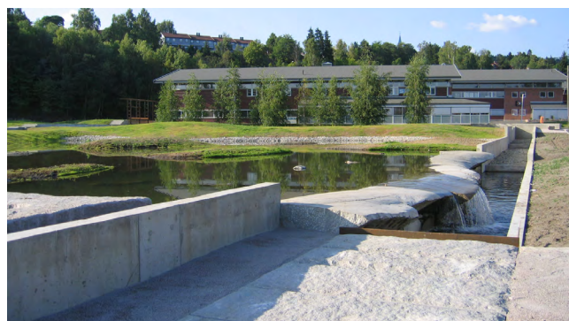
Fig. 45 : Piscine écologique avec rétention et trop-plein
