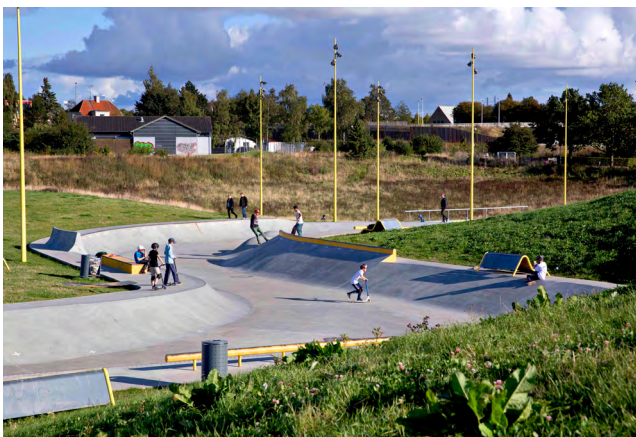
Fig. 85 : À Roskilde, le canal alimentant le bassin de rétention sert aussi de skatepark
