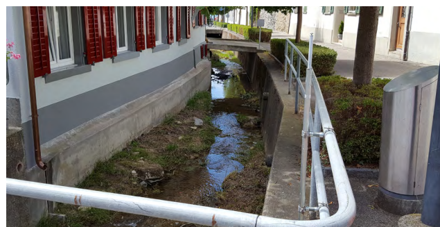
Fig. 34 : Le ruissellement est acheminé dans le Talerbach via la route
