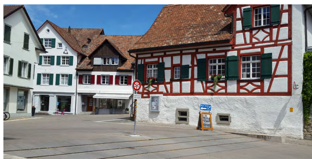
Fig. 33 : Seuil à l'entrée du centre historique visant à dévier le ruissellement à Steckborn
