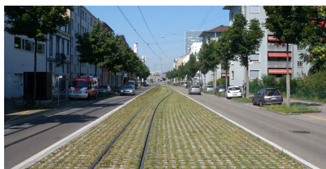
Fig. 38 : Horburgstrasse à Bâle, voie de tramway après sa végétalisation
