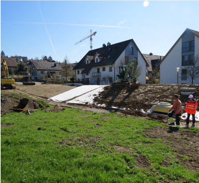
Fig. 24 : Digue rehaussée avec l'ouvrage de sortie et le trop-plein de sécurité surélevé
