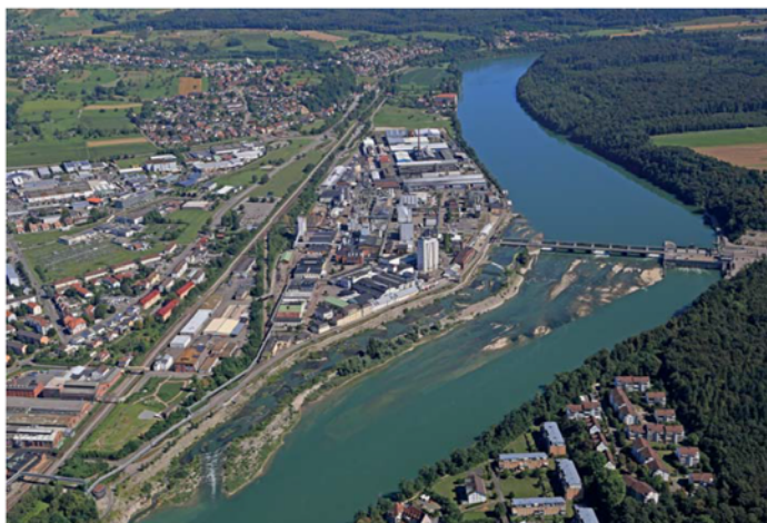
Bild 2b. Kraftwerk Rheinfelden mit Umgehungsgewässer (links) und Vertical-Slot-Fischpass (rechte Uferseite); Foto: Energiedienst.
