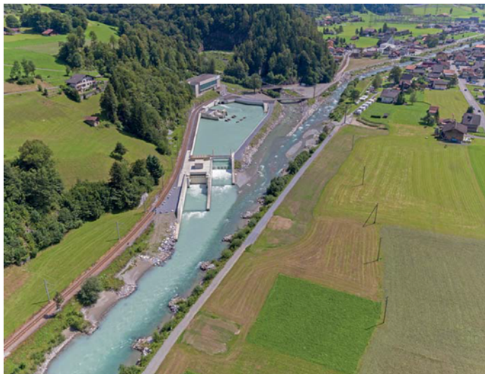
Bild 2a. Ausgleichsbecken Kraftwerke Oberhasli (KWO); Foto: Markus Zeh, Bremgarten.
