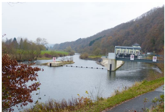
Bild 3: Wasserkraftwerk Unkelmühle an der Sieg, Blick vom Oberwasser (Quelle: A. Peter)
