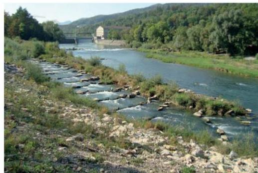
**Bild 7.** Dank diesem 660 Meter langen Umgehungsgewässer stellt die Staustufe des Kraftwerks Ruppertswil-Auenstein (AG) für aufsteigende Fische seit 2006 kein unüberwindbares Hindernis mehr dar (Bild: Departement Bau, Verkehr und Umwelt des Kantons Aargau).
