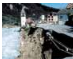
OUVRAGES DE PROTECTION CONTRE LES CRUES
