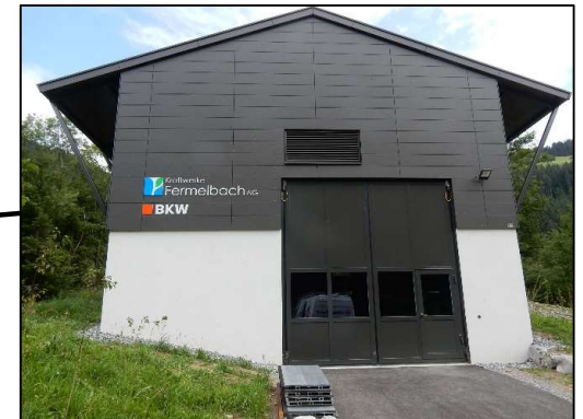
WKW Fermelbach (Kraftwerke Fermelbach AG)
