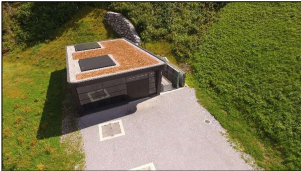
WKW Laubegg (Simmentaler Kraftwerke AG)
