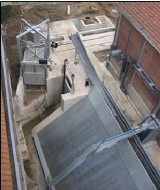
Bild 3 Wasserkraftanlage in Roermond (NL), ausgerüstet mit einem vertikalen Fischschutz-Rechen mit einem Stababstand von 10 mm, links im Bau, rechts in Betrieb-
