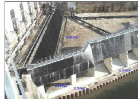
Photo 7 : Détail du masque lors des travaux
