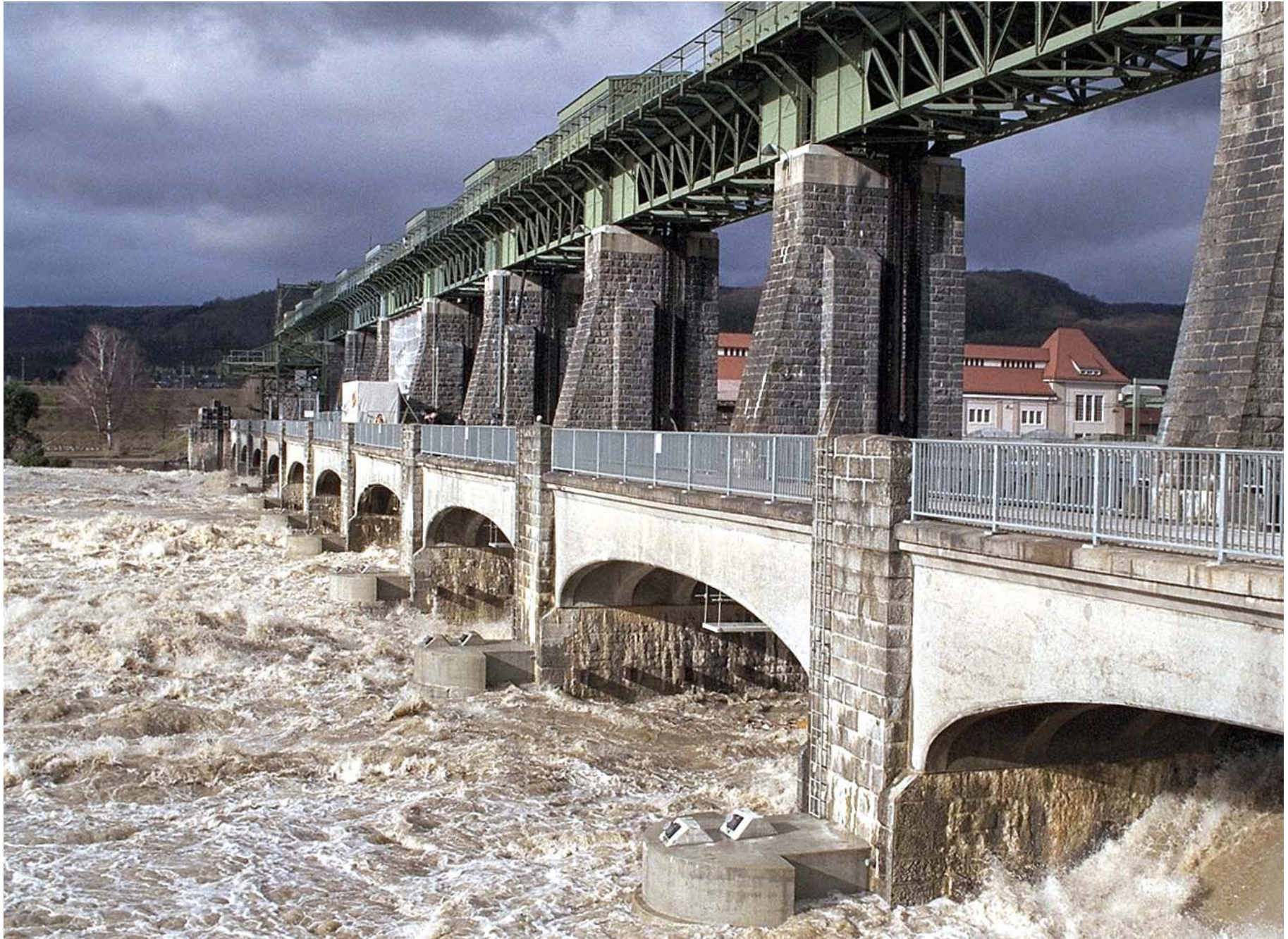
Wehrüberfall beim Hochwasser am KW Augst-Wyhlen (32 MW, 750 m 3 /s) am Hochrhein, Foto: SWV
