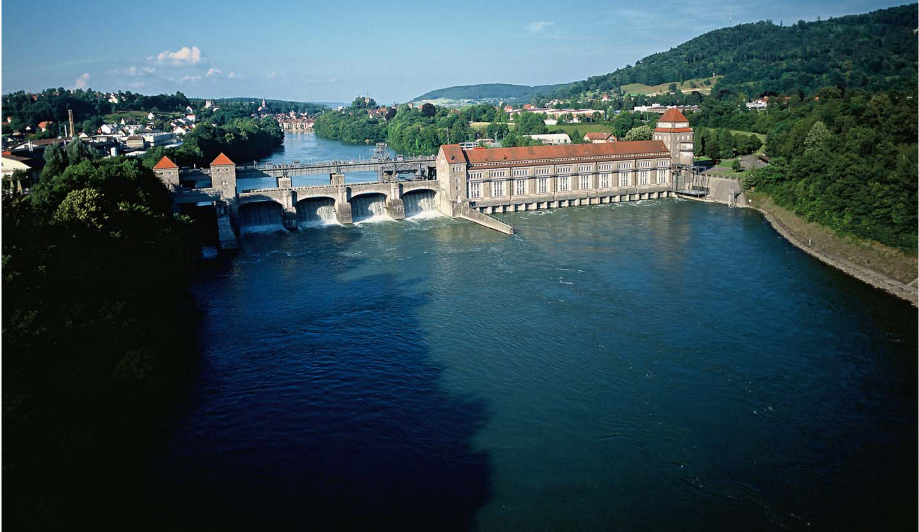
Wehrfelder und Maschinenhaus des KW Laufenburg am Hochrhein, Quelle: ED
