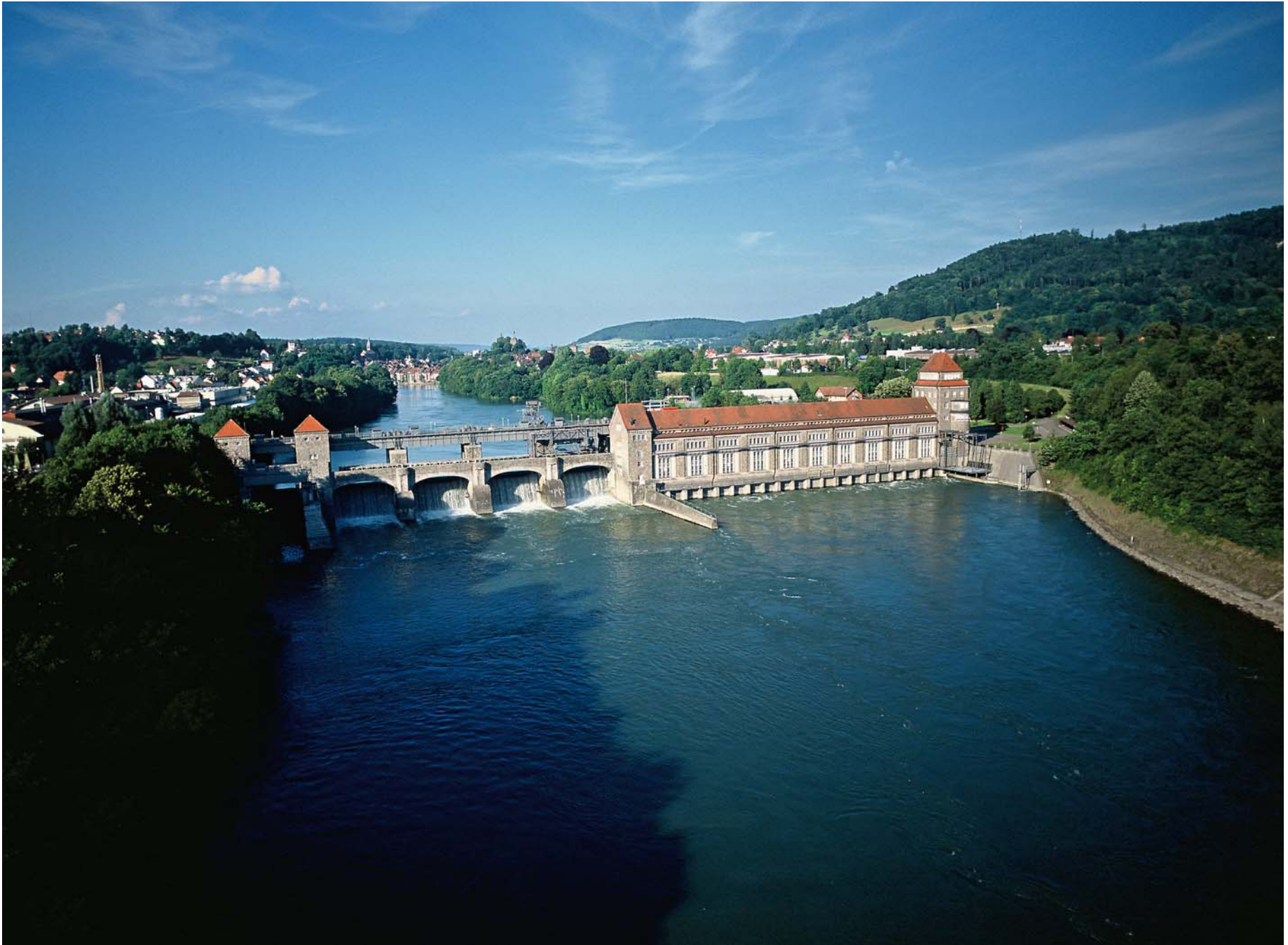
Wehrfelder und Maschinenhaus des KW Laufenburg am Hochrhein, Quelle: ED
