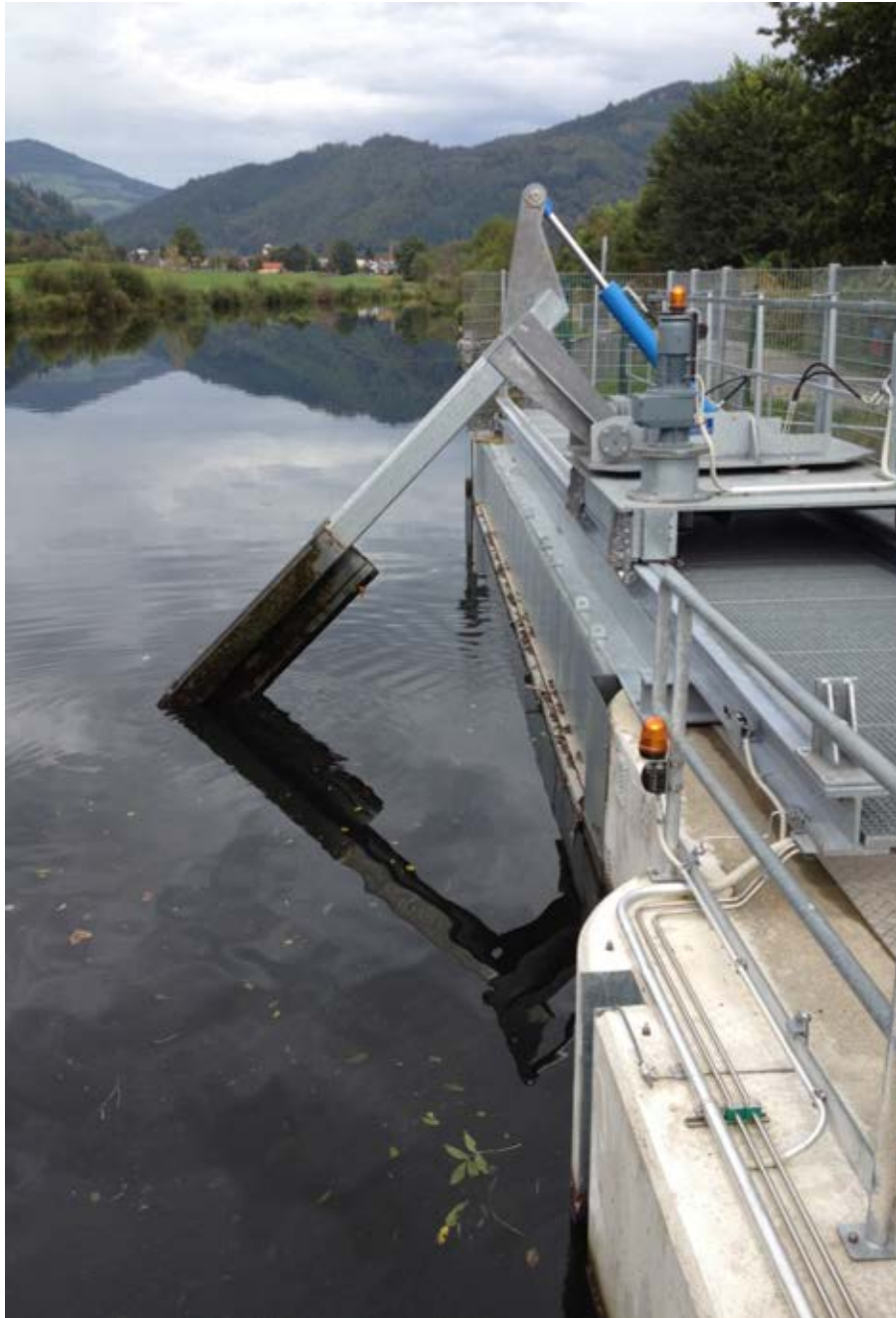
Fischabstiegsanlage mit Horizontalrechen, Bypassgerinne und Abschwemmrinne beim KW Fahrnau (0.4 MW, 9 m 3 /s) an der Wiese/D, Foto: SWW/Pfa, 2014
