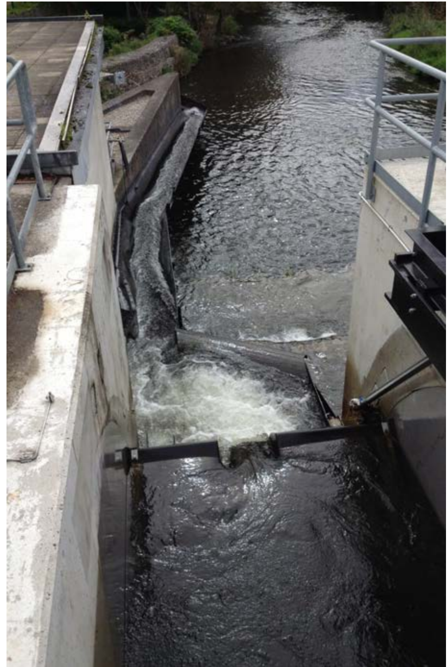
Fischabstiegsanlage mit Horizontalrechen, Bypassgerinne und Abschwemmrinne beim KW Fahrnau (0.4 MW, 9 m 3 /s) an der Wiese/D, Foto: SWW/Pfa, 2014
